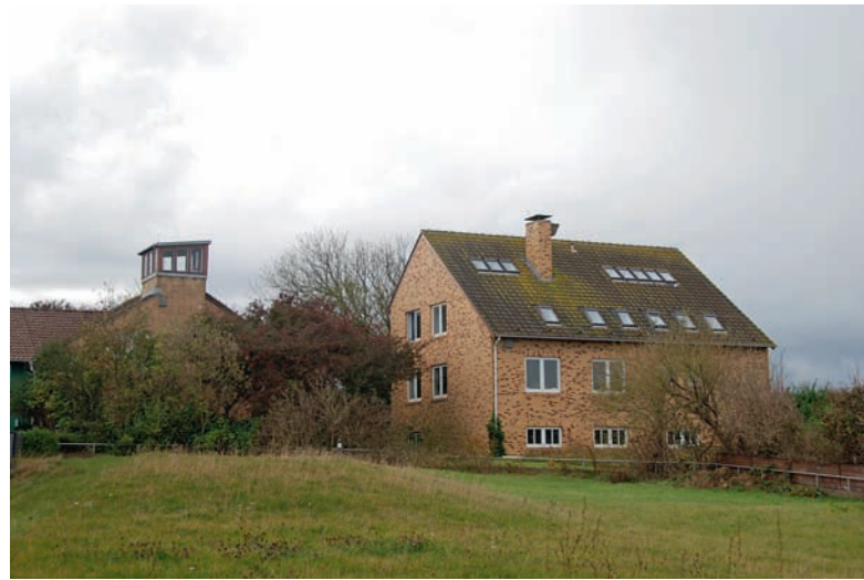
Heutige Inselstation des IFV: Links das 1957 errichtete Gebäude mit Beobachtungsturm, rechts das 1985 bezogene Labor- und Wohngebäude (Kathrin Hüppop, 12.10.2009). – Today's island station of the IFV: To the left the building constructed in 1957, to the right the new laboratory and residential building used since 1985.
